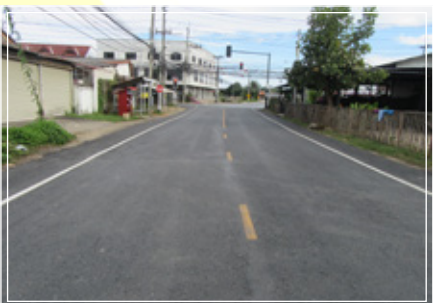
ลาดยางแอสฟัลต์ติกถนนบ้านกลาง
